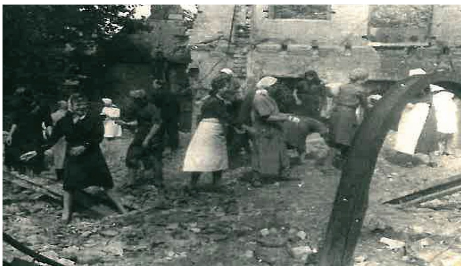
Arbeiterinnen beim Wiederaufbau
